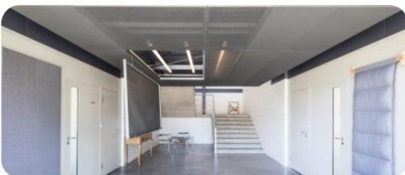
Selon les besoins, chaque panneau du plafond Strato, respirant ou absorbant, peut devenir une trappe invisible qui ne change pas l'aspect du plafond et permet facilement l'accès au plénum. Un loquet très discret permet d'ouvrir la trappe.
